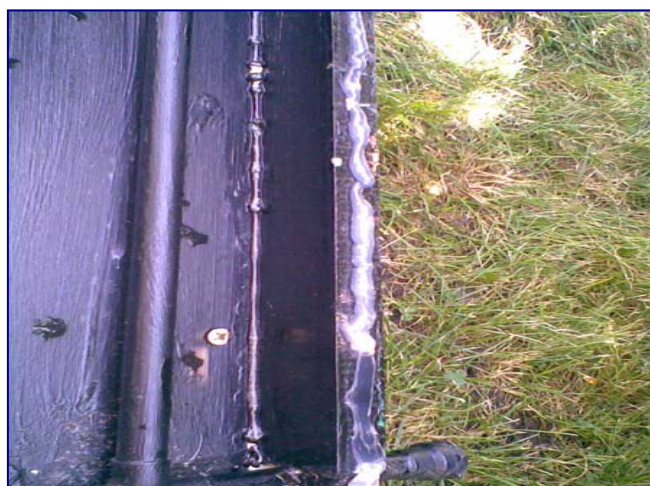
Zdjęcie 14 Uszczelnienie silikonowe (źródło: http://www.douamaini.ro/ )
