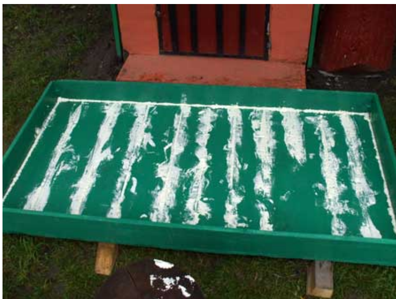
Zdjęcie 9 Izolacja skrzynki drewnianej pianką poliuretanową (źródło: http://www.douamaini.ro/ )
