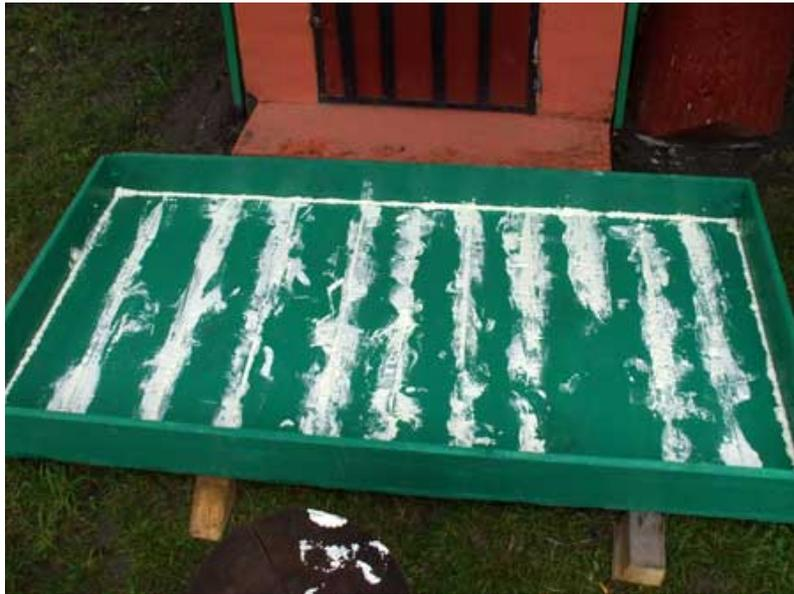
Foto 9 Die Isolierung der Holzkiste mit Polyurethan-Schaumstoff
